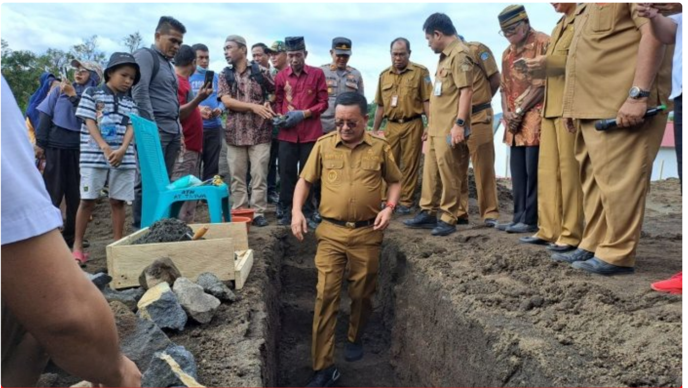
Wali kota Bitung Ir. Maurits Mantiri MM, Peletakan Batu pertama pembangunan Mesjid di Waleleng Pinokalan
